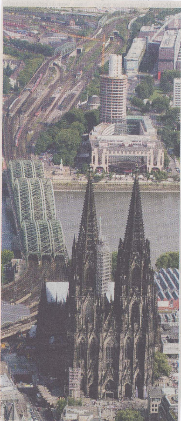
Nadelöhr Hohenzollernbrücke: Der Hauptbahnhof ist längst an seine Kapazitätsgrenzen gestoßen.
