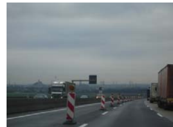
... Verkehrskommission und Regionalrat Köln fassen Beschlüsse zu den Straßenbauprogrammen...
